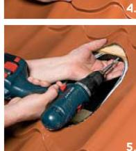
5. При битумной гидроизоляции нижнюю поверхность уплотнителя промазать резинобитумной мастикой. Прижать уплотнитель к гидроизоляции и закрепить шурупами к деревянной основе.
