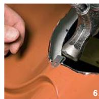
6. Насадить молотком клипсы на металлическую черепицу в верхней и нижней точке крепежа проходного элемента так, чтобы при крепеже шурупы прошли сквозь клипсы.
