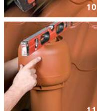
11. Установить Viile изделие на проходной элемент, проверив вертикальность уровнем, и закрепить шурупами.
