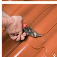
2. Вырезать отверстие в металлической черепице электролобзиком строго по очерченному контуру.
