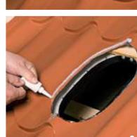
8. Смазать силиконом очерченный участок между краем отверстия и линией внешнего контура.
