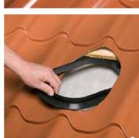
3. Вставить уплотнитель гидрозатвора в вырезанное отверстие, совместить отверстие уплотнителя с отверстием металлической черепицы.
