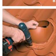
9. Установить проходной элемент и закрепить сначала верхний и нижний край шурупами через клипсы.
