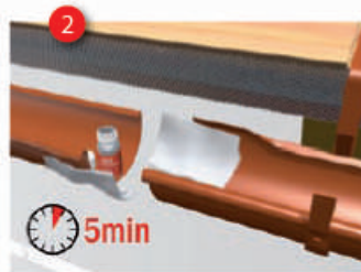
Обезжирьте склеиваемые поверхности растворителем. Подождите 5 минут, пока испарится остаток растворителя.
